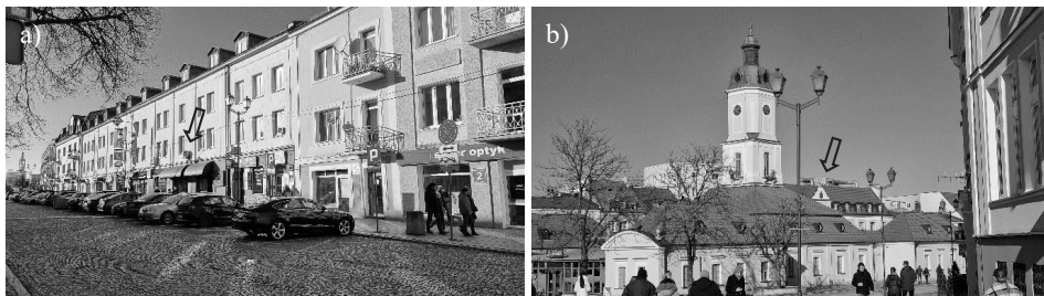
Rysunek 4. Urządzenia wentylacji i klimatyzacji widoczne od strony przestrzeni publicznych
